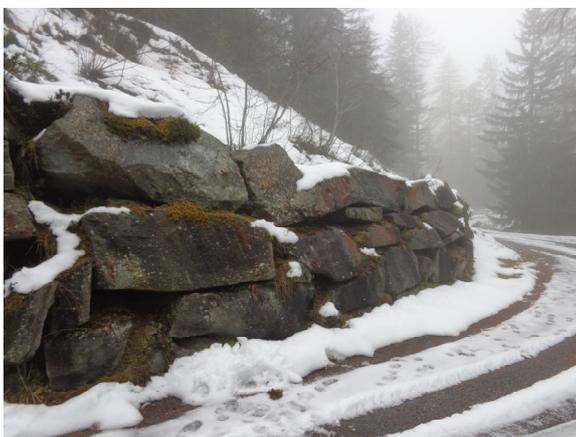
Abbildung 3: Mauer Nr. 4 mit sehr grossen Fugen
