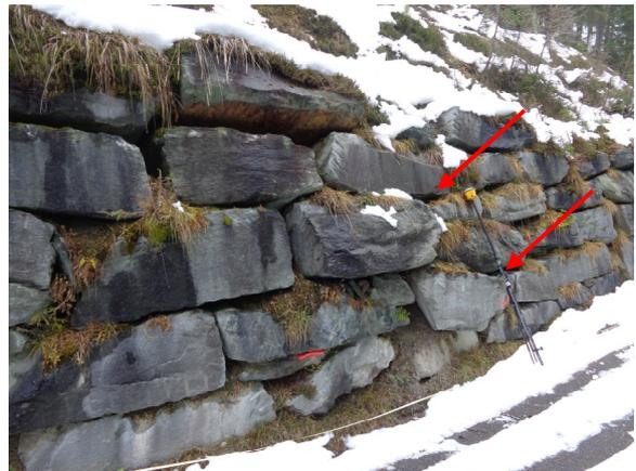
Abbildung 2: Mauer Nr. 1 mit aus der Mauer herausragenden Blöcken (Pfeile)
