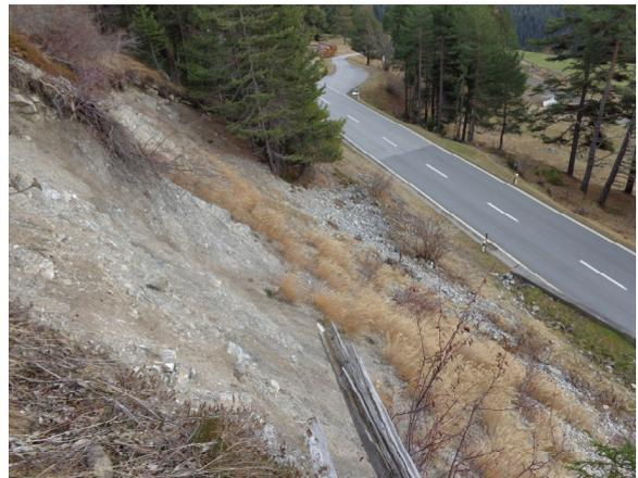
Abbildung 8: Erosionsböschung zwischen Alpweg und Kantonsstrasse
