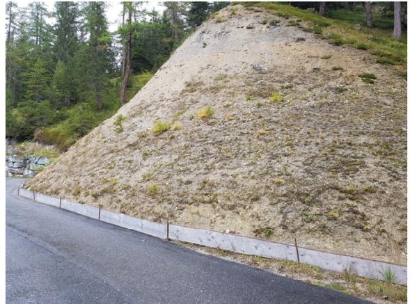
Abbildung 11: Erosionsböschung bergseitig des Alpwegs
