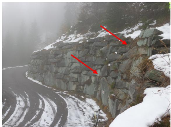
Abbildung 4: Mauer Nr. 5 mit viel zu steilem Anzug und stark verformtem Bereich (Pfeil: unten Bauch, oben eingefallen)
