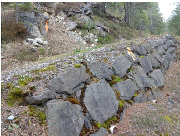
Abbildung 18: Blocksteinmauer in Beton. Die Pfeile kennzeichnen ein ehemaliges Leck in der Milchleitung im Jeepweg
