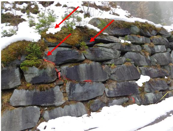
Abbildung 1: Mauer Nr. 1 mit losem Blockverbund im oberen Bereich und Bewuchs in und auf der Mauer
