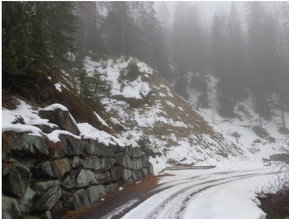
Abbildung 10: Erosionsböschung bergseitig des Alpwegs
